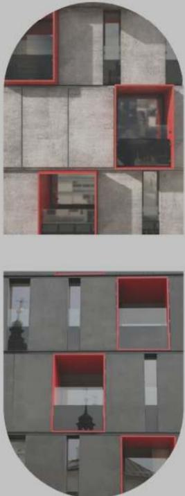
Modèle d'encadrement des ouvertures en panneaux colorés
